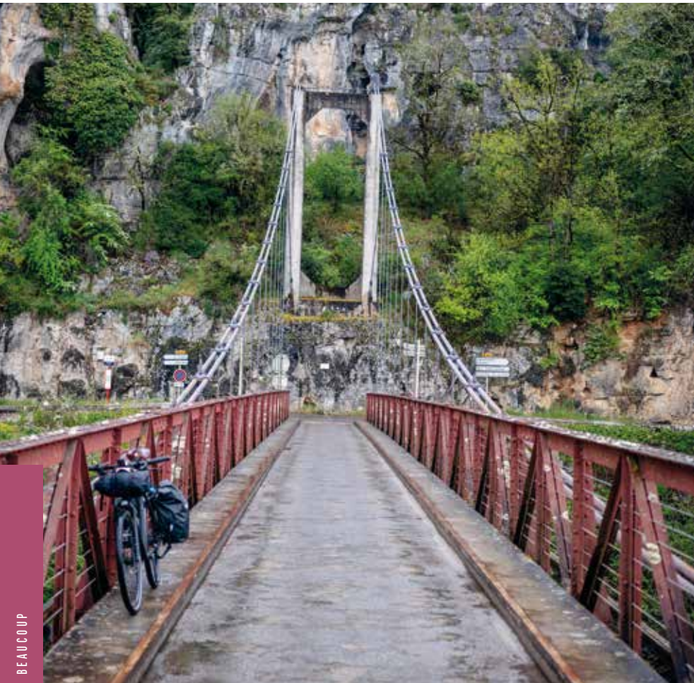
Jonction Le pont de Bouziès se trouve à la confluence du Lot et du Célé.
